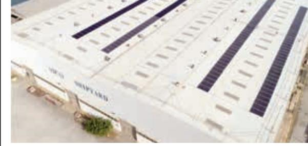
Hesablamalara görə, Abşeronda il ərzində 2200-2400 saat günsüz hava şəraitidir. Buna görə də zavodda quraşdırılan sistem vasitəsilə il ərzində 240-260 MWh elektrik enerjisini istehsal edilməsi gözlənilir.
